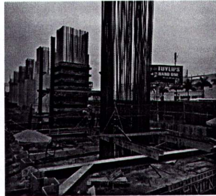
Dự án đường sắt đô thị tuyến Cát Linh Hà Đông
